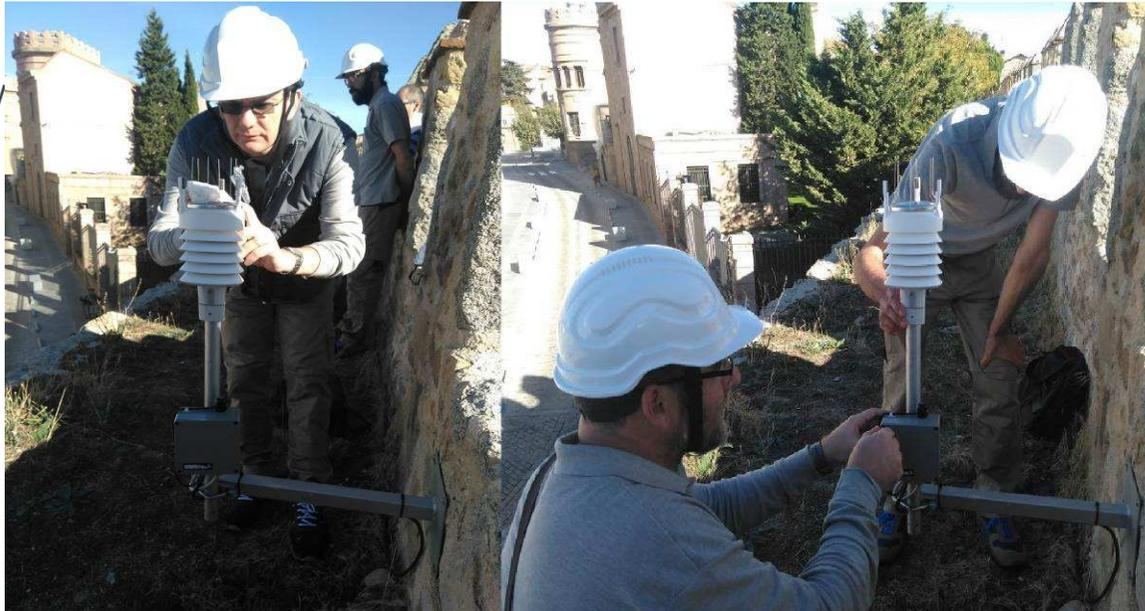
Instalación y configuración de una estación meteorológica en un punto de la muralla de Ávila.
